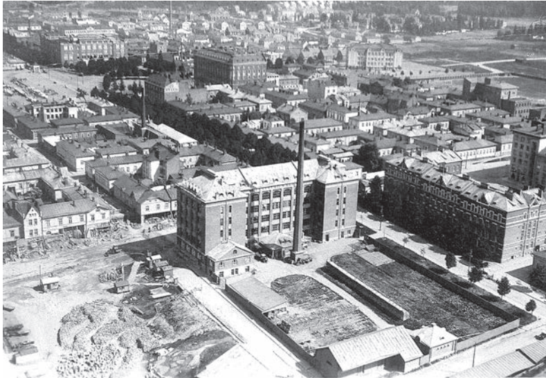
Attilan kenkätehdas keskellä, oikeassa reunassa Toralinna. Korttelin 311 pohjoisreunaa ja paikalla sijainneet matalat rakennukset kuvan oikeassa alakulmassa. Valokuva rautatieaseman rakentamisen ajalta v.1935-36. Emil Aaltosen museon kokoelmat.
