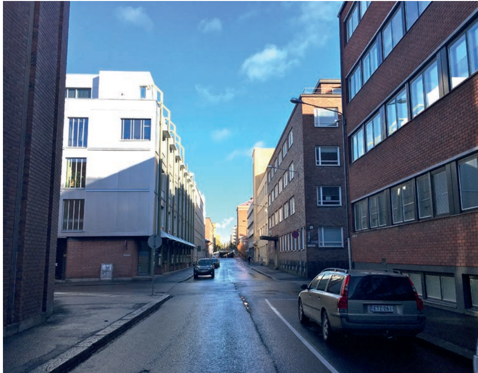
Edessä vasemmalla pysäköintitalon (11) kulmaa ja oikealla Lääketehtas Starin laajennus (18). Taaempana vasemmalla KOY Hammareeni (9).
